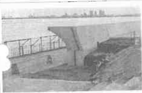
(波返しの形状 コンクリートの厚みが分かります)
