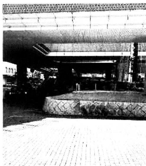
JR芦屋駅北側のロータリーの樹木周辺の構造物を撤去すればバス停を確保する余裕が生まれます。
