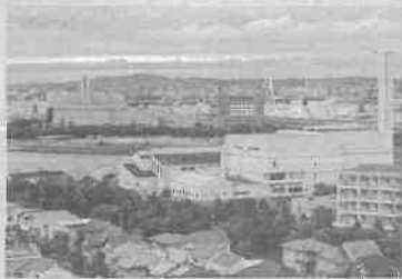
芦屋浜から見た2つの焼却施設
