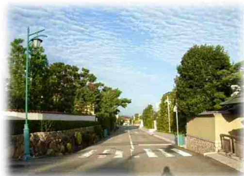
既に無電柱化されている六麓荘町のまちなみ
