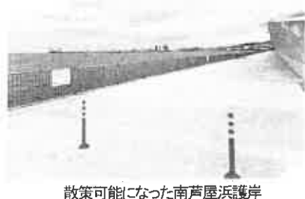
散策可能になった南芦屋浜護岸
