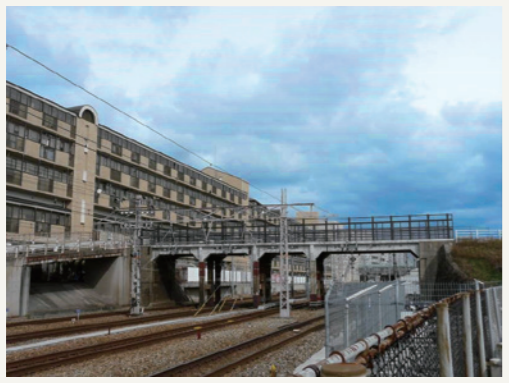
撤去される第一跨線橋
