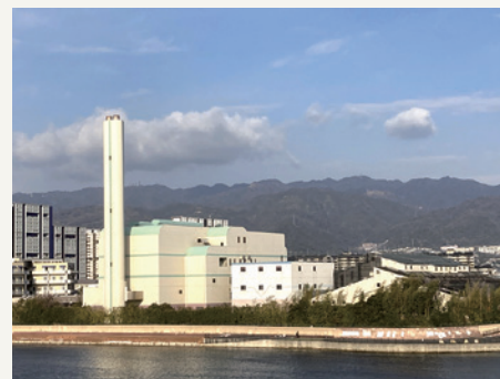
芦屋市環境処理センター
