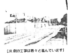
【JR側の工事は着々と進んでいます】
