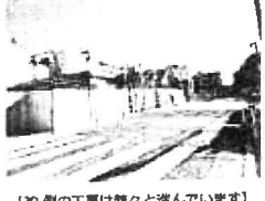
【JR側の工事は徐々に進んでいます】
