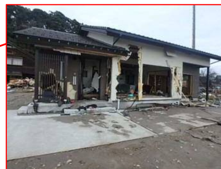
津波によって 壁が破壊さ れた家
