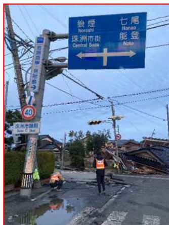
陥没した電柱(宝立地区)
