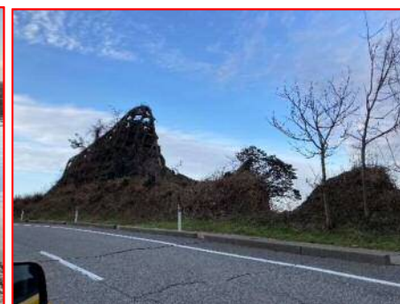
崩落し擁壁だけ残った崖
