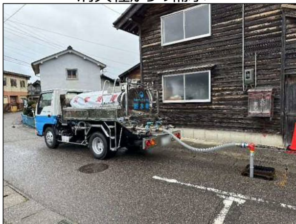
消火栓からの補水
