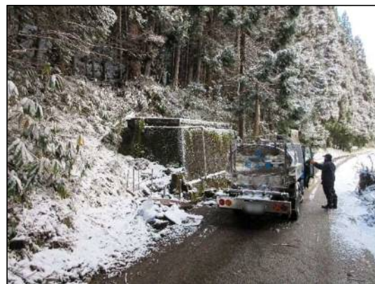
河内集会所上流タンク
