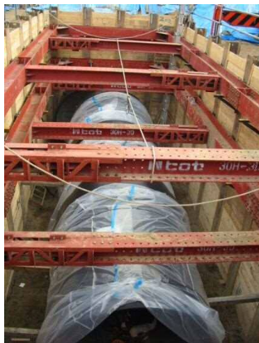
平成20年度 西芦屋ポケットパーク (耐震性貯水槽 60 m 3 )
