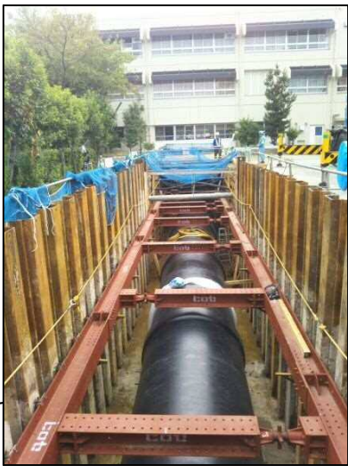
平成30年度施工 打出浜小学校の耐震性貯水槽100m 3
