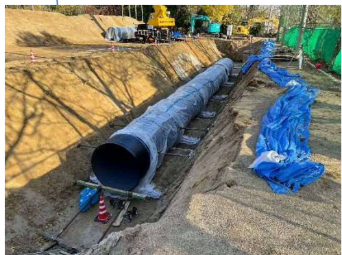
令和3年度 施工 山手中学校の耐震性貯水槽 60m 3
