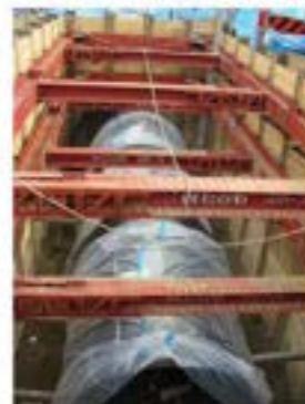
【耐震性貯水槽の設置工事の様子】
