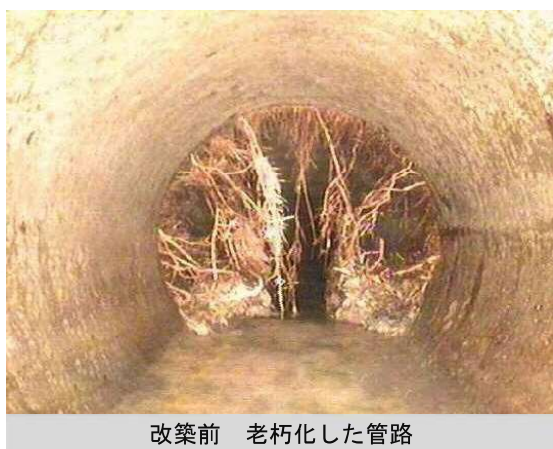
写真7 管路の改築状況
