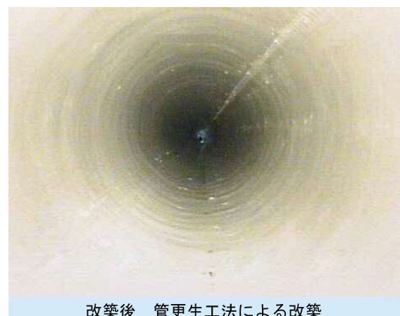
写真7 管路の改築状況
