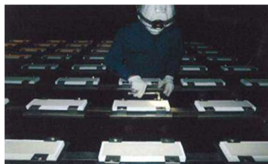
改築後 新たな散気装置
