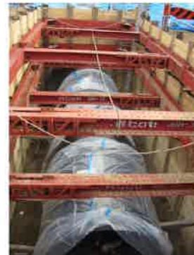
【耐震性貯水槽の設置工事の様子】
