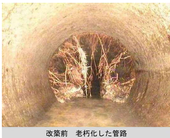
写真 7 管路の改築状況
