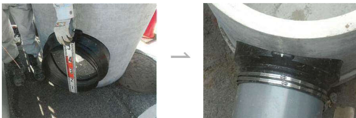
写真9 マンホールと管路の接続部の耐震化
