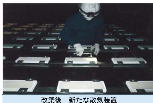
写真 8 機械設備の改築状況
