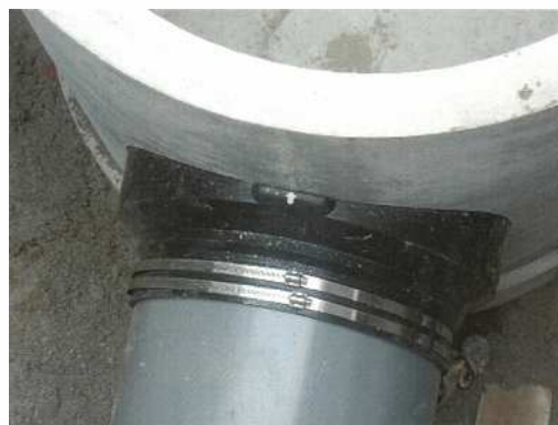
写真 9 マンホールと管路の接続部の耐震化
