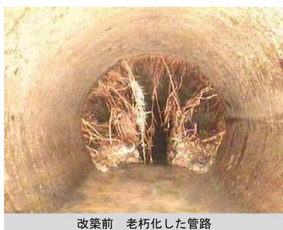
写真 7 管路の改築状況
