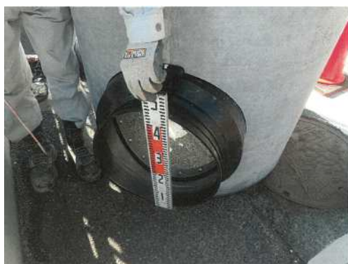
写真 9 マンホールと管路の接続部の耐震化
