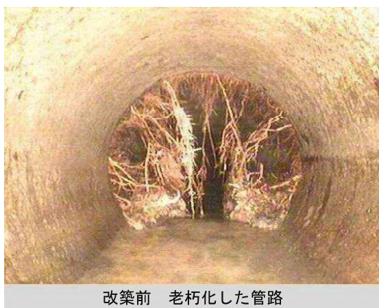
写真7 管路の改築状況
