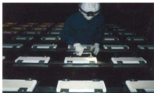
改築後 新たな散気装置
