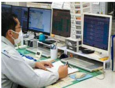
【処理施設の運転管理】
