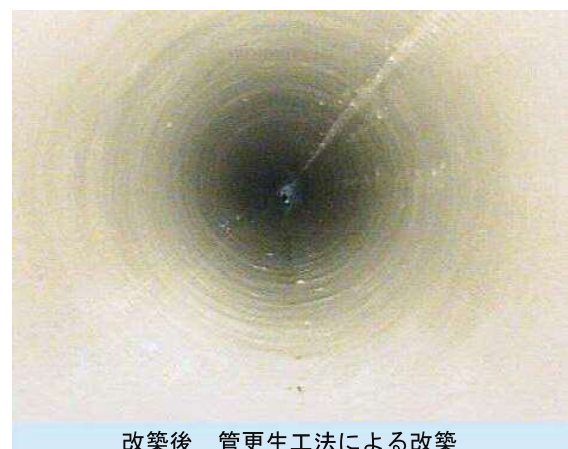
写真7 管路の改築状況
