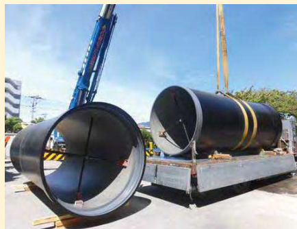
打出浜小学校に耐震性貯水槽を設置している様子（平成30年）
