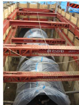
【耐震性貯水槽の設置工事の様子】
