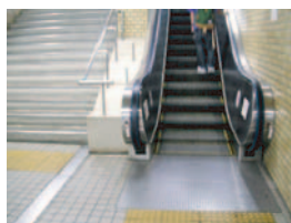
▲エレベーターが設置されていない
