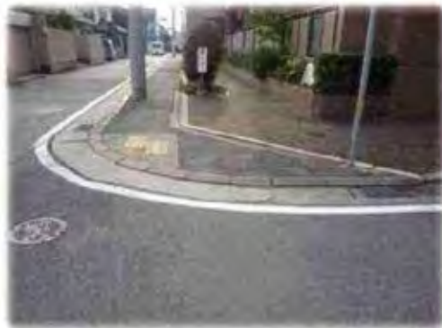
歩道の切下げ（改修前）
