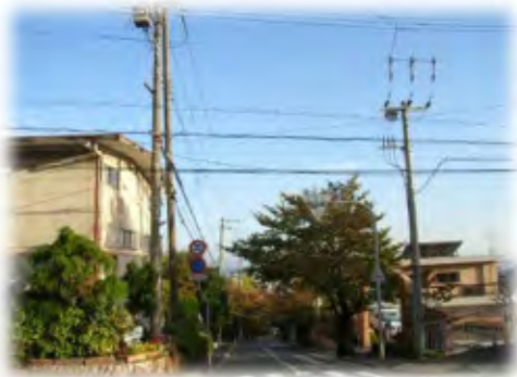
無電柱化（整備前）
