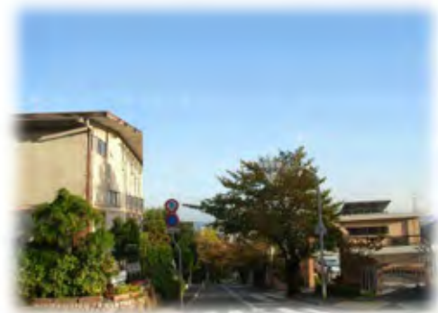
無電柱化（整備後）
