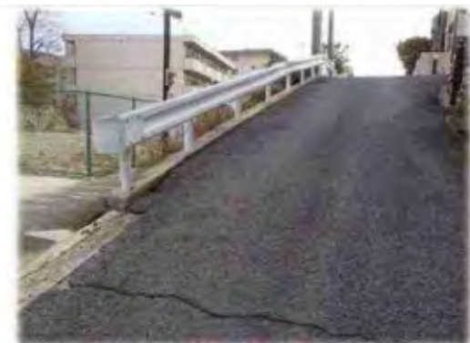
防護柵（改修前）
