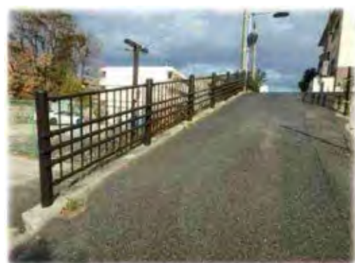
防護柵（改修後）
