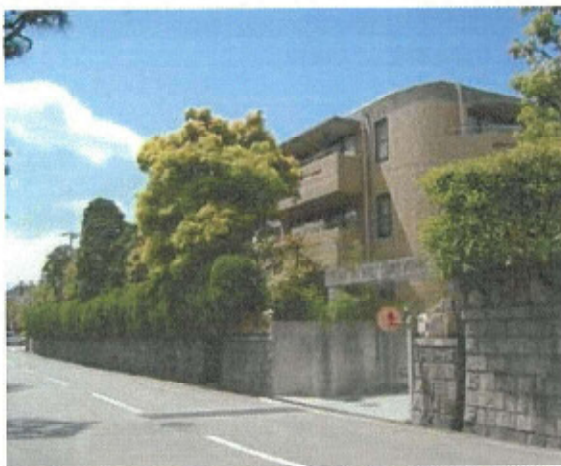
既存の緑と外構を残し、元の環境を生かしつつ十分な植栽を施している例
