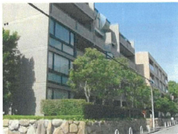
外構素材や建築物の明度を隣地の施設と近いものとしている例
