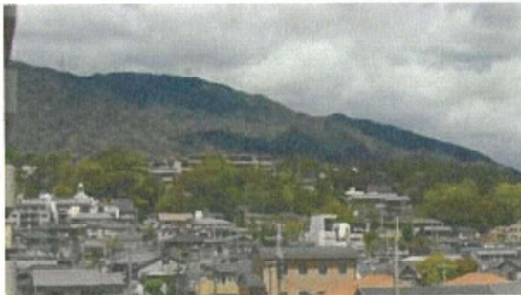
山裾では建物が緑の中にとけ込み、背景の斜面の緑と一体感のある外観とする
