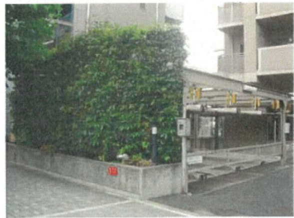
機械式駐車場の鉄骨が通りに露出しないよう、接道部に修景植栽を施している例
