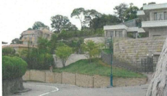
壁面と表情の異なる擁壁により分節化するとともに、緑化によりうるおいを創出している例
