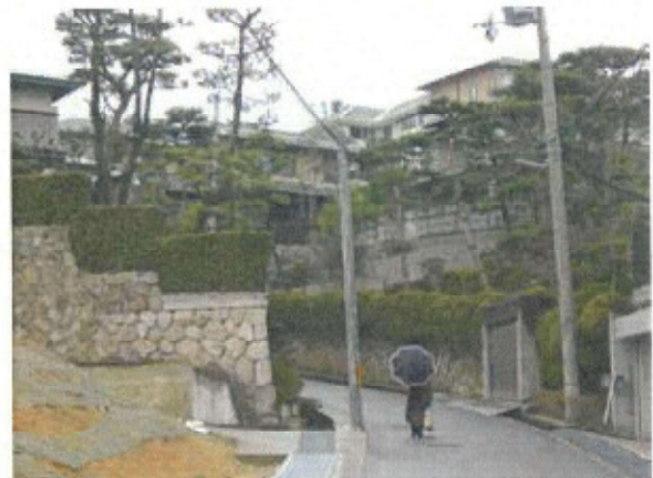
擁壁を徐々に立ち上げ、緑化した法面と効果的に組み合わせている例
