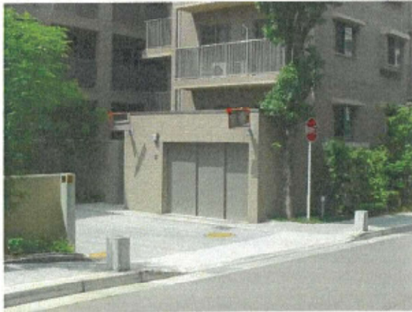
ゴミ置場を道路から見えにくい位置に配置するとともに、建築デザインと一体化させ、建築物と調和した意匠とした例
