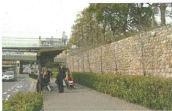
玉石積みの表情のある壁面とし、壁面後退部と上部に緑化することでうるおいを演出している例
