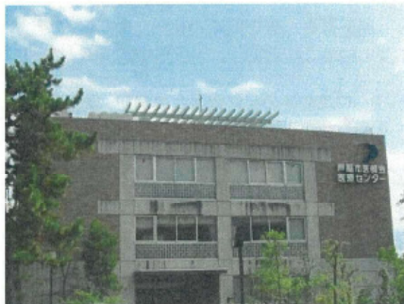
屋上設備をルーバーで覆って修景している例
