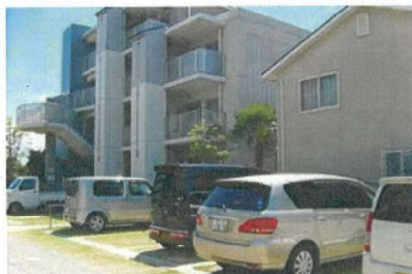
駐車場の車路の舗装を工夫し、路面を緑の空間としてしつらえている例
