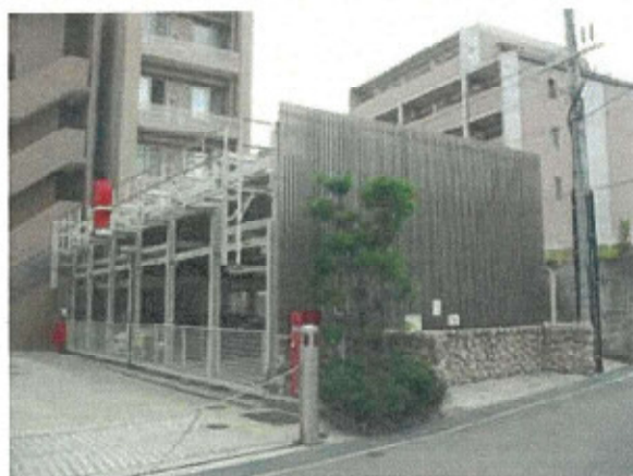
緑化と目隠しパネルにより機械式駐車場を修景している例
