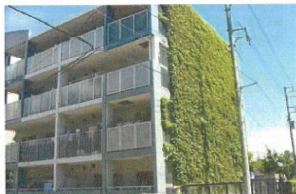
開口部の少ない壁面が通りに面し、十分なセットバックもできない場合の壁面緑化による工夫例
