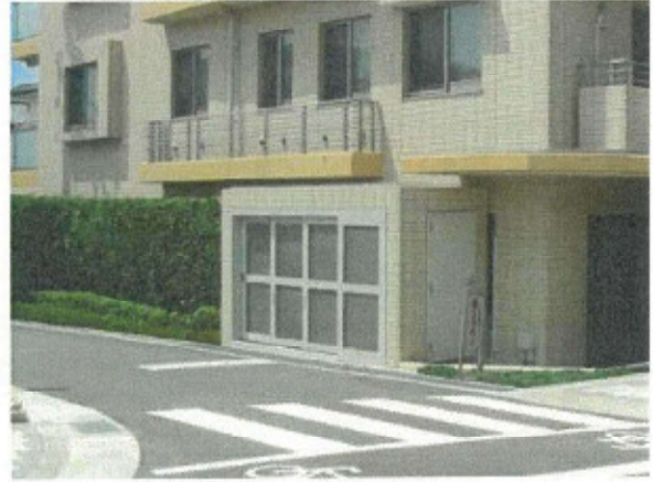
建築物と一体化したデザインとすることで、通りに面したゴミ置場の存在感を軽減している例
