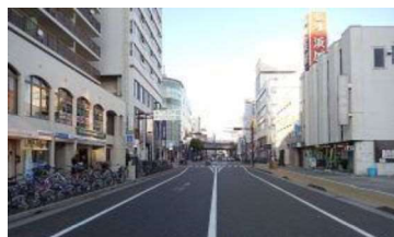
無電柱化整備状況(伊丹市)
