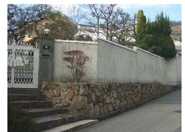
玉石積みによる擁壁の例
