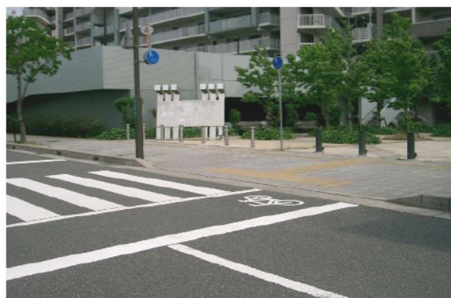
歩道の段差解消
