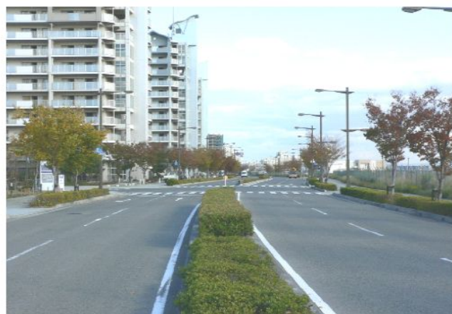
電線類地中化の整備
