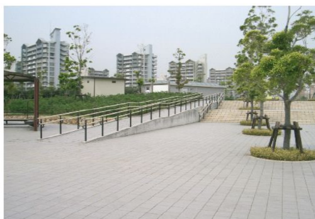
スロープを伴った階段の整備(親水中央公園)
