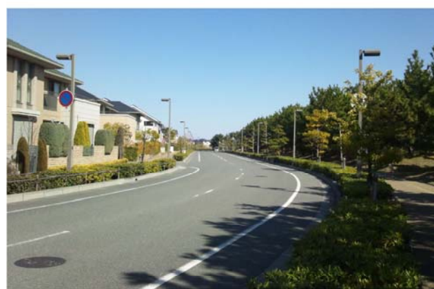
電線類地中化の整備
