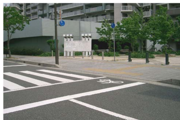
歩道の段差解消
