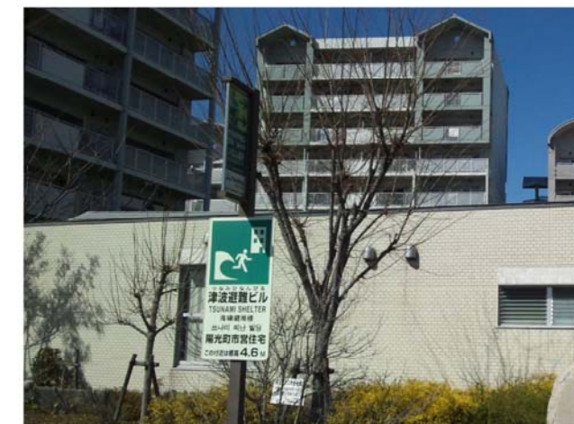
津波避難ビルに指定されている市営住宅
