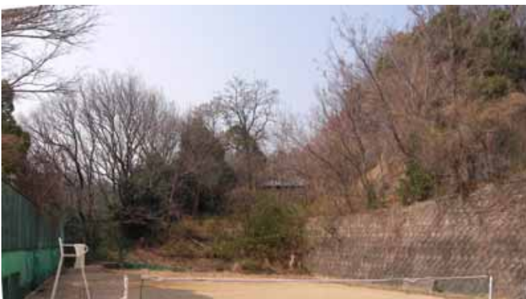
D部の現況写真(三条地区 )
