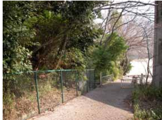
C部の現況写真(三条地区 )
