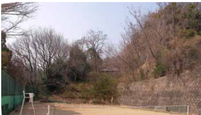
D部の現況写真(三条地区)
