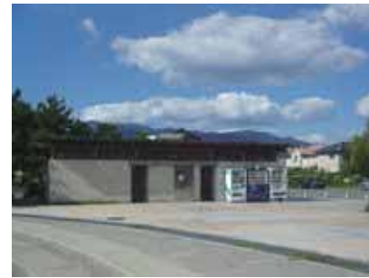
▼公衆トイレ(東駐車場側)
