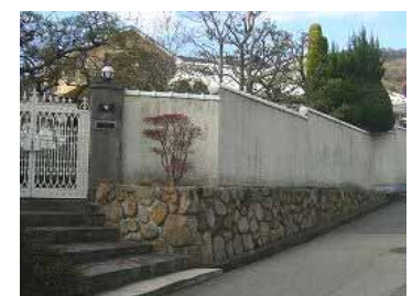
玉石積みによる擁壁の例
