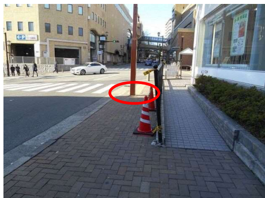
幅員が狭い（施設へのスロープ、信号機）
