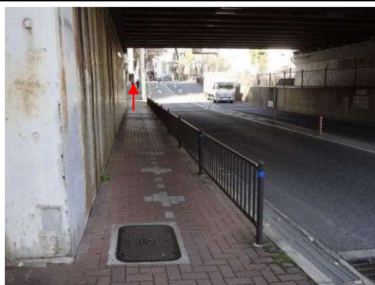
歩道の勾配がきつい
