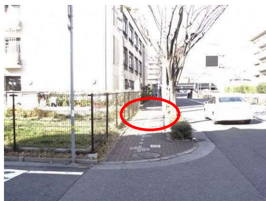
歩道幅員が狭い（南側）
