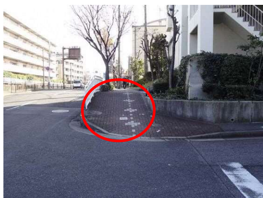
スロープ勾配がきつい（北側）
