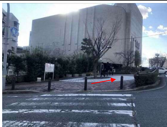
歩道の勾配がきつい
