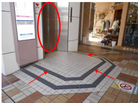
出入口の幅が狭い、出入口の前の勾配がきつい
