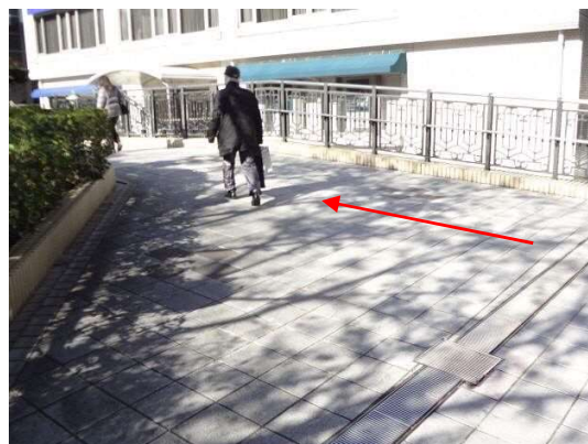
スロープ勾配がきつい
