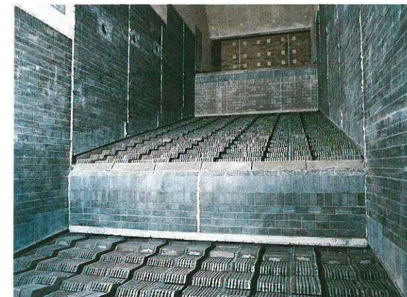
火格子 燃焼装置も高クロム耐熱耐腐耗鋼製の往復動階段火格子(3段)で構成され、攪拌性を高める反転グレートブロック装置も配しています。
