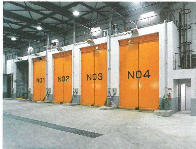
プラットフォームとごみ投入扉 ごみピットにごみを投入します。
