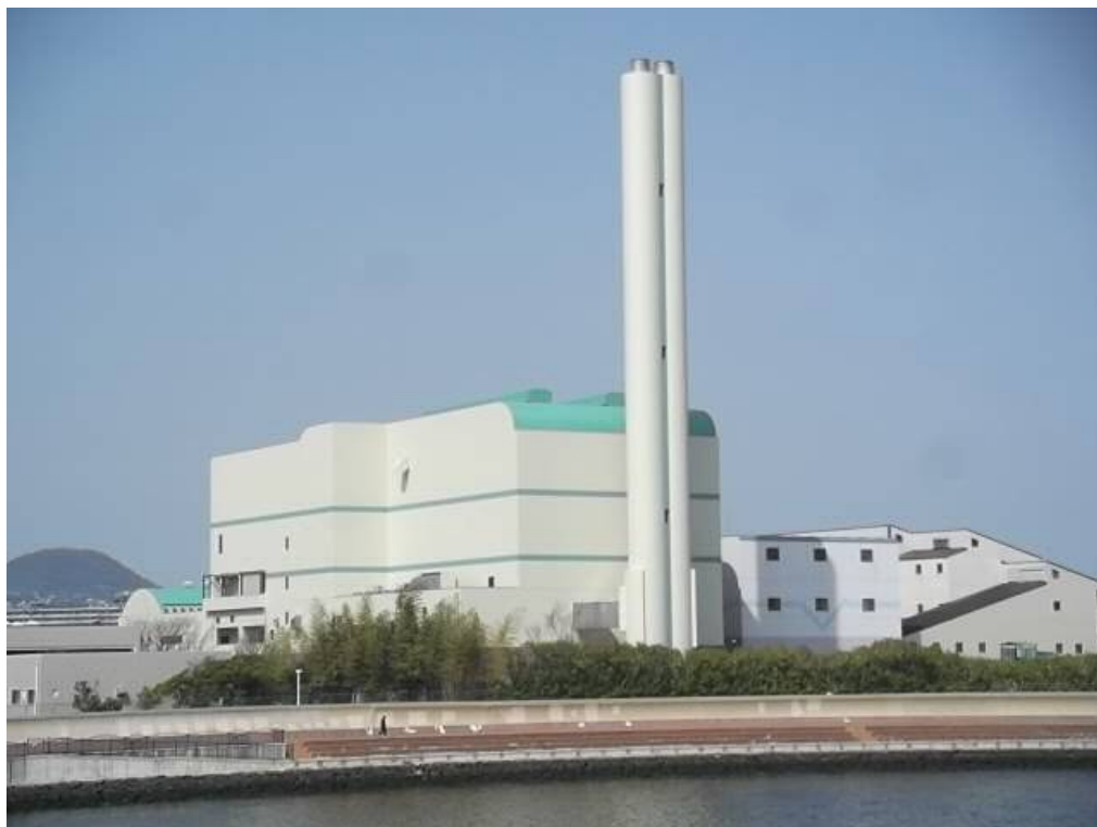
(写真：環境処理センター)
