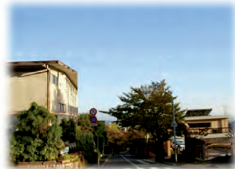
無電柱化（整備後）
