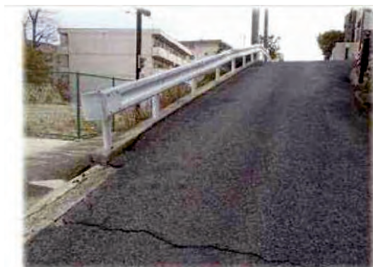
防護柵（改修前）
