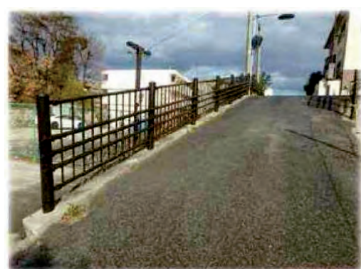
防護柵（改修後）
