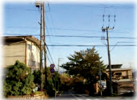
無電柱化（整備前）
