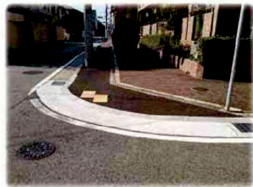
歩道の切下げ（改修後）
