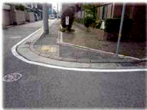
歩道の切下げ（改修前）
