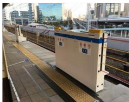
昇降式ホーム柵の設置例
