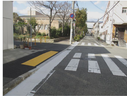
歩道の切下げ（改修後）
