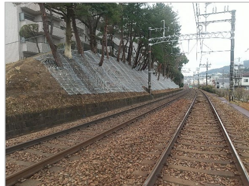
法面（線路南側）の様子
