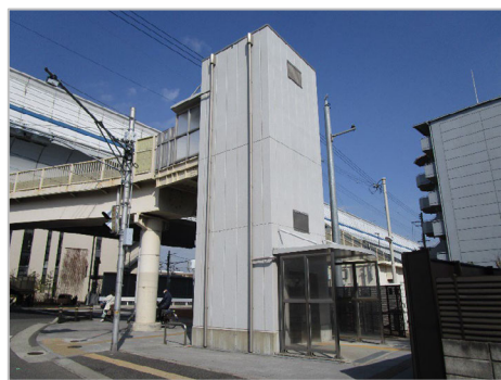
参考写真（国道43号精道交差点）
