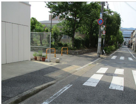
歩道の切下げ（改修前）
