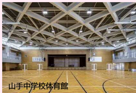
精道中学校体育館
